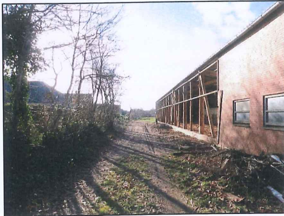
Abbildung 12: Abbruchgebäude und östl. Knick
